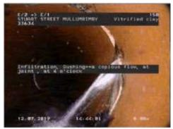
Joint displaces longitudinaly, longitudinal displacement 21-30cm
